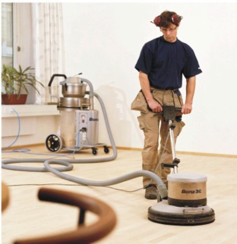
Začínáme brusným papírem nebo mřížkou se zrnitostí P60 a končíme dle požadovaného povrchu u zrnitosti P100 / P120.
