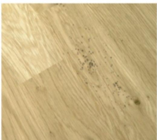
To samé se stane s drobnými železnými pilinami. Tyto částice mohou vznikat při broušení hřebíků nebo při vybíhání brusného pásu na ocelový kryt pracovního válce některých typů válcových brusek.
